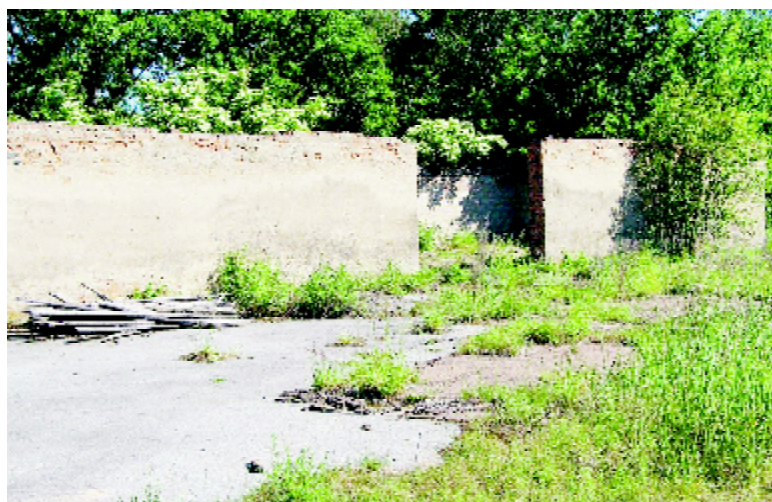
Строение, которое будет восстанавливаться под пилораму
