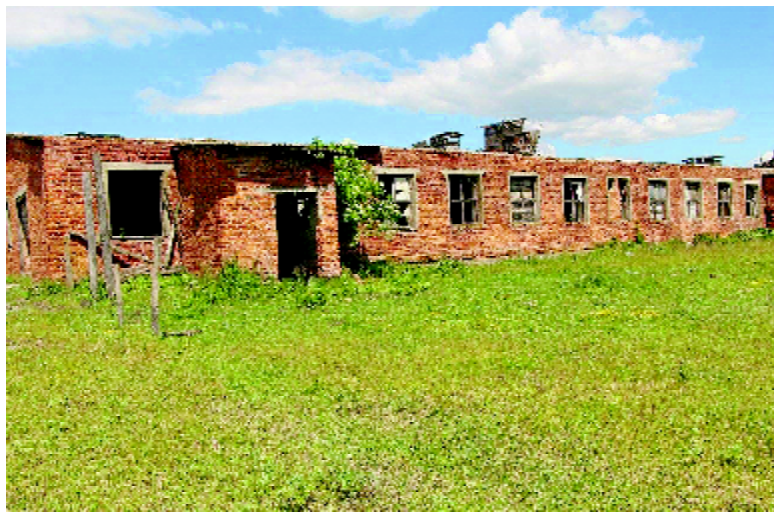
Приобретённое строение под демонтаж
