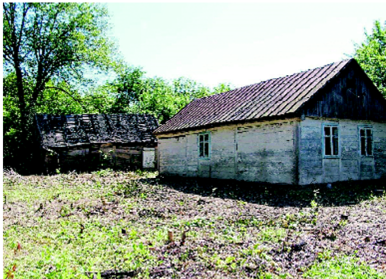
Очередной заброшенный дом подготавливается под ремонт
