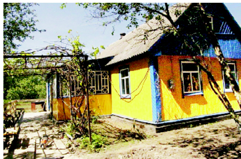
Первый лесной отремонтированный дом, со всеми подведёнными бытовыми коммуникациями: свет, вода, канализация
