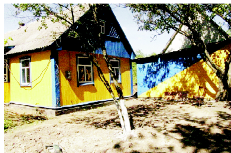
Возле дома также отремонтированы подсобные помещения
