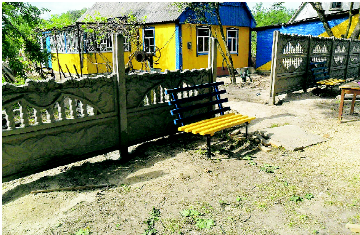
Последние ремонтные штрихи возле первого отремонтированного дома
