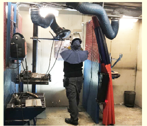
Ув'язнена за зварювальними роботами
